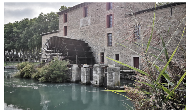
Le Moulin Saint-Pierre des TAILLADES
