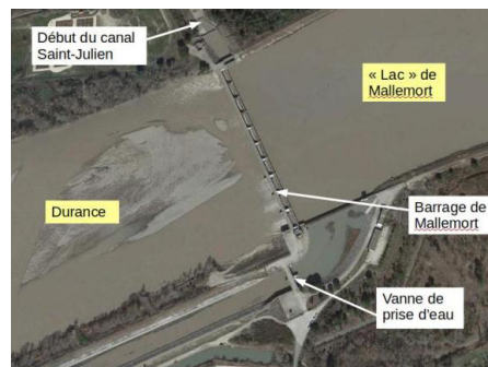
Vue aérienne de la prise d'eau du canal de Carpentras et du canal Saint-Julien
