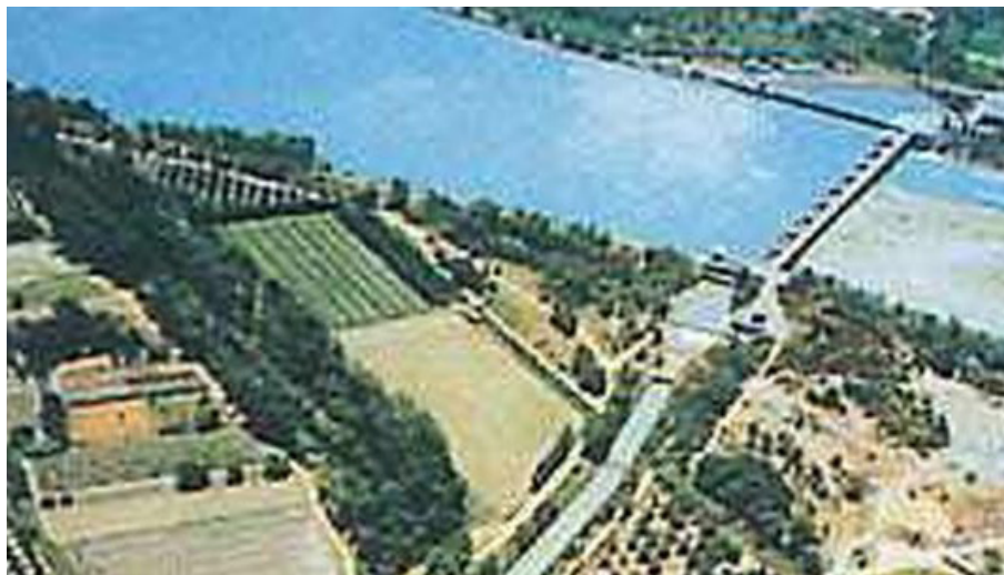
La prise d'eau de Mallemort dans les Bouches du Rhône
